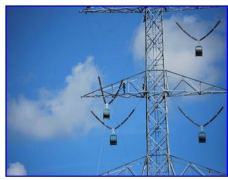
ขั้นตอนที่ 5 งานติดตั้งเสาโครงเหล็กและแขวนลูกถ้วยเตรียมงานชิงสาย
