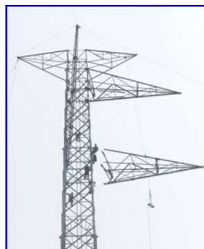
ขั้นตอนที่ 5 งานติดตั้งเสาโครงเหล็กและแขวนลูกถ้วยเตรียมงานชิงสาย
