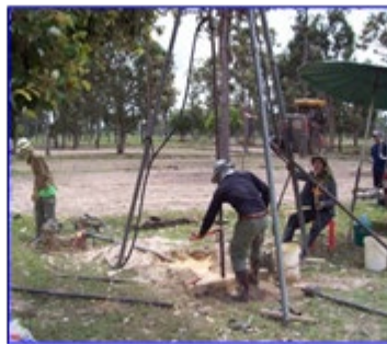
ขั้นตอนที่ 2 - 4 งานเจาะสำรวจชั้นดิน งานตัดต้นไม้ และงานก่อสร้างฐานราก
