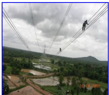
ขั้นตอนที่ 6 งานชิงสายไฟฟ้า และตรวจสอบสายส่งไฟฟ้าก่อนจ่ายไฟ
